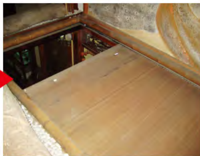
W1,500×D4,000 アルミ製、電動式、BOX型、木目仕様
