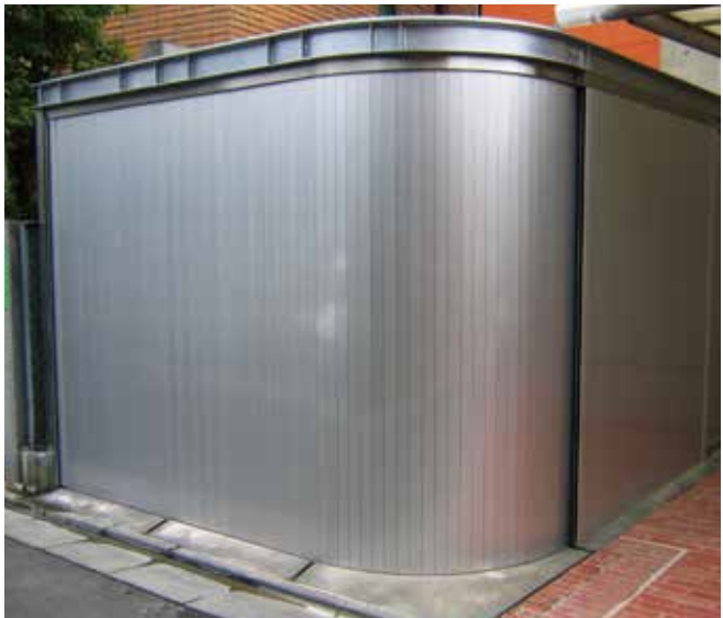
W3,100×H2,200 アルミ製・電動式・ガレージ用横引きシャッター
