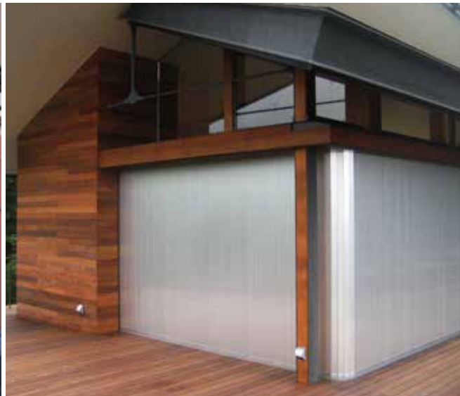
W7,200×H2,500 アルミ製・電動式・雨戸用横引きシャッター
