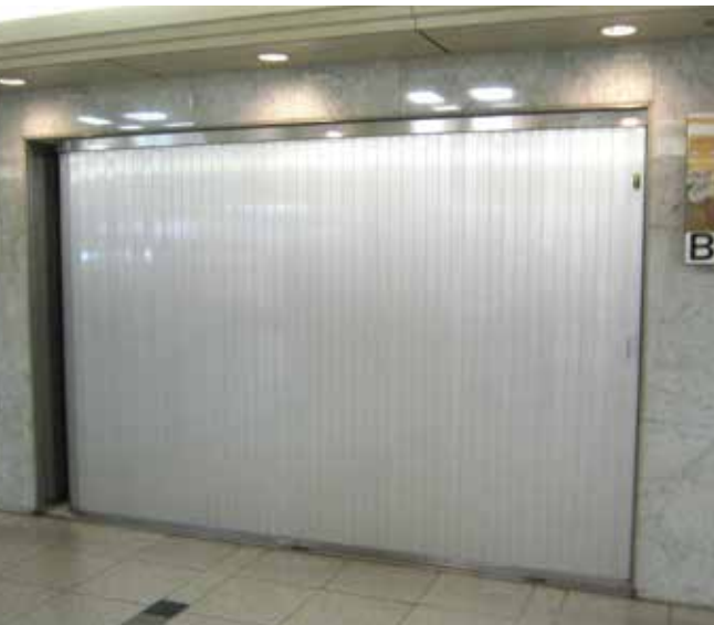
W3,000×H2,100 アルミ製・電動式・売店用横引きシャッター
