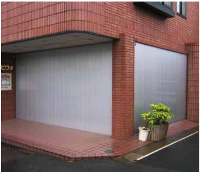
W4,000×H2,700 アルミ製・電動式・店舗用横引きシャッター
