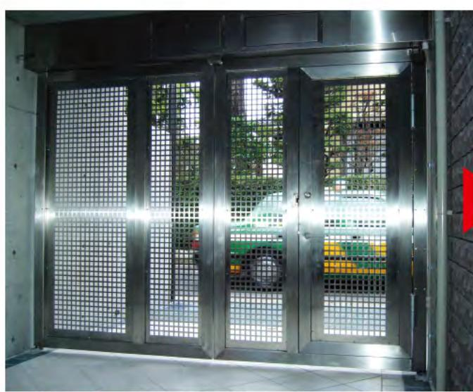
ぐぐり戸付き W3,500×H2,500 ステンレス製、観音開き型、アルミパンチングパネルタイプ、ぐぐり戸手動・電気錠付き、※開き戸仕様
