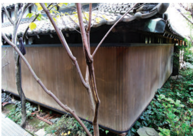
約・W15,000×H2,300 アルミ製（木製シート貼り） 電動式、片引き仕様、BOX型、曲げR=200
