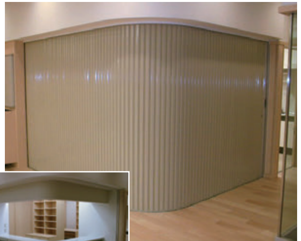
約・W5,500×H2,700 スチール製(ベージュ塗装) 手動式、片引き仕様、BOX型 t=0.8、防火戸仕様
