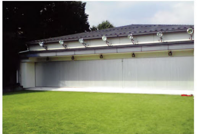
W14,000×H2,500 アルミ製(シルバー) 手動式、両引き分け仕様、BOX型
