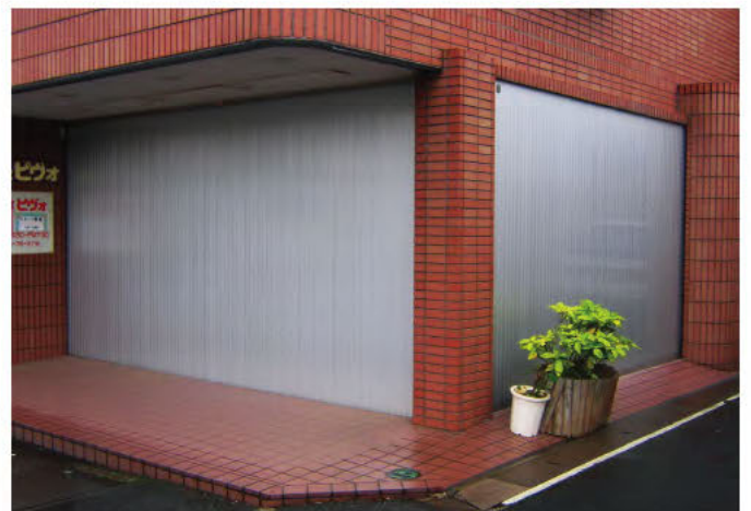
W4,000×H2,700 アルミ製(シルバー) 電動式、片引き仕様、BOX型
