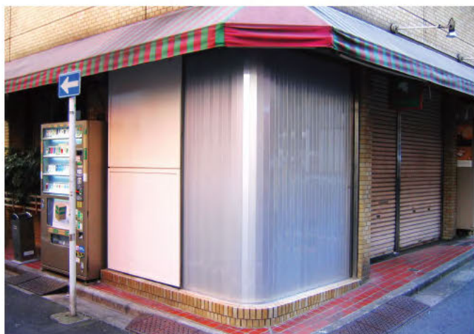
W2,300×H2,700 アルミ製(シルバー) 手動式、片引き仕様、BOX型、曲げR=300
