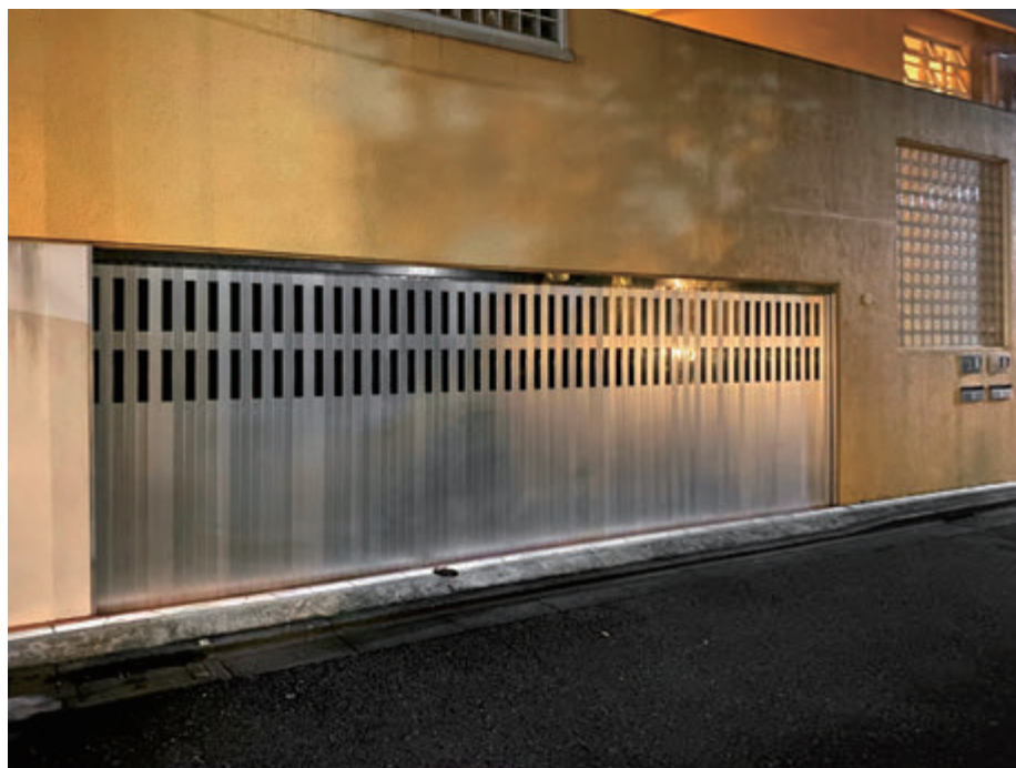
約・W5,600×H2,300 アルミ製（シルバー）電動式、片引き仕様、BOX型
