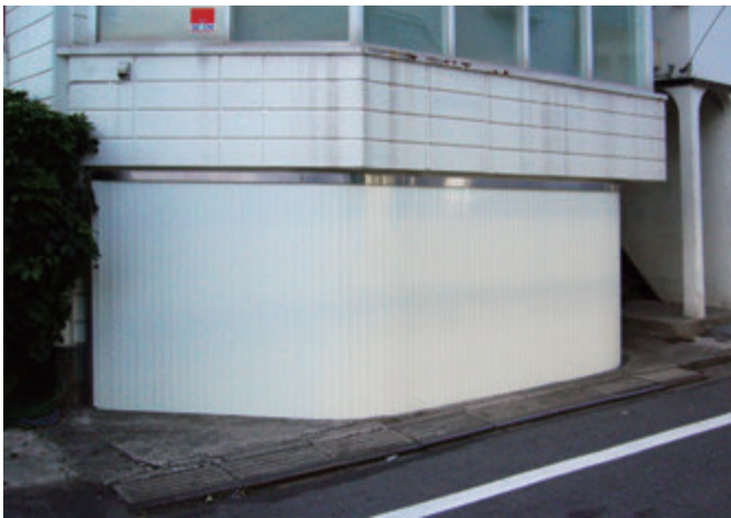
約・W9,000×H2,600 スチール製（ホワイト） 手動式、片引き仕様、BOX型、2カ所カーブ有り
