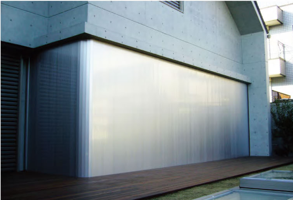
W7,000×H2,700 アルミ製(シルバー) 電動式、片引き仕様、BOX型、曲げR=300
