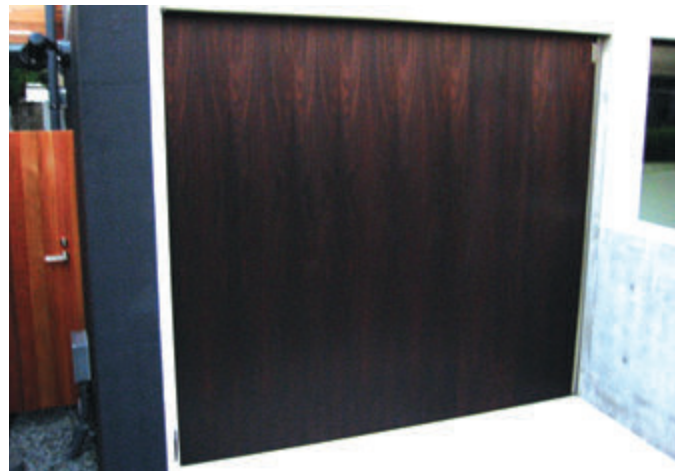
約・W2,500×H2,300 アルミ製（ダイノックシート貼り） 電動式、片引き仕様、流し込み型
