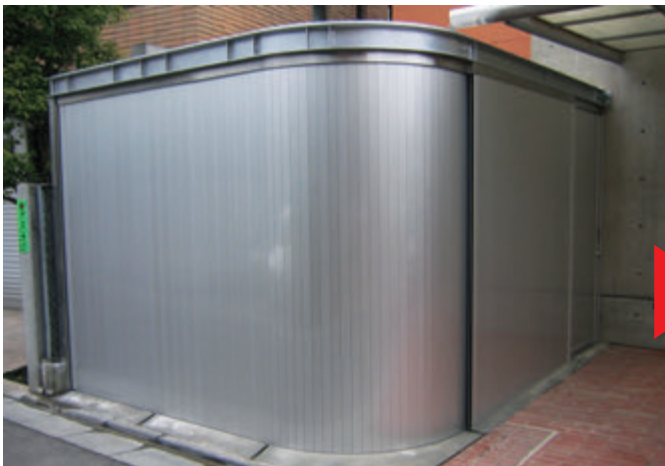
約・W3,100×H2,200 アルミ製（シルバー）電動式、片引き仕様、BOX型、曲げR=600
