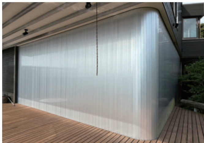
約・W11,000×H2,700 アルミ製（シルバー）電動式、片引き仕様、BOX型、曲げR=300
