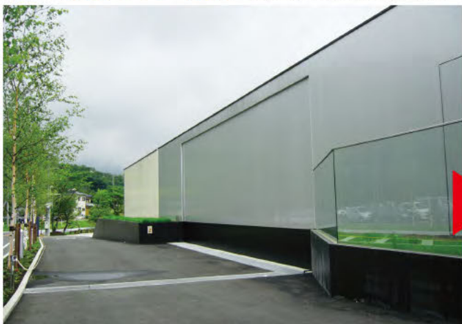
W10,185×H3,800 アルミ製(ブラック・シルバー2色特殊仕様) 電動式、片引き仕様、BOX型 ※「ブラック L=600」+「シルバー L=3,200」=TH3,800
