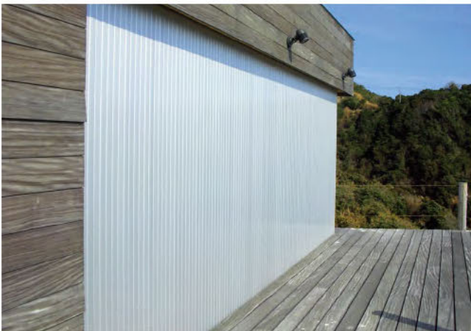
W9,000×H2,700 アルミ製(シルバー) 電動式、片引き仕様、BOX型、 曲げR=300
