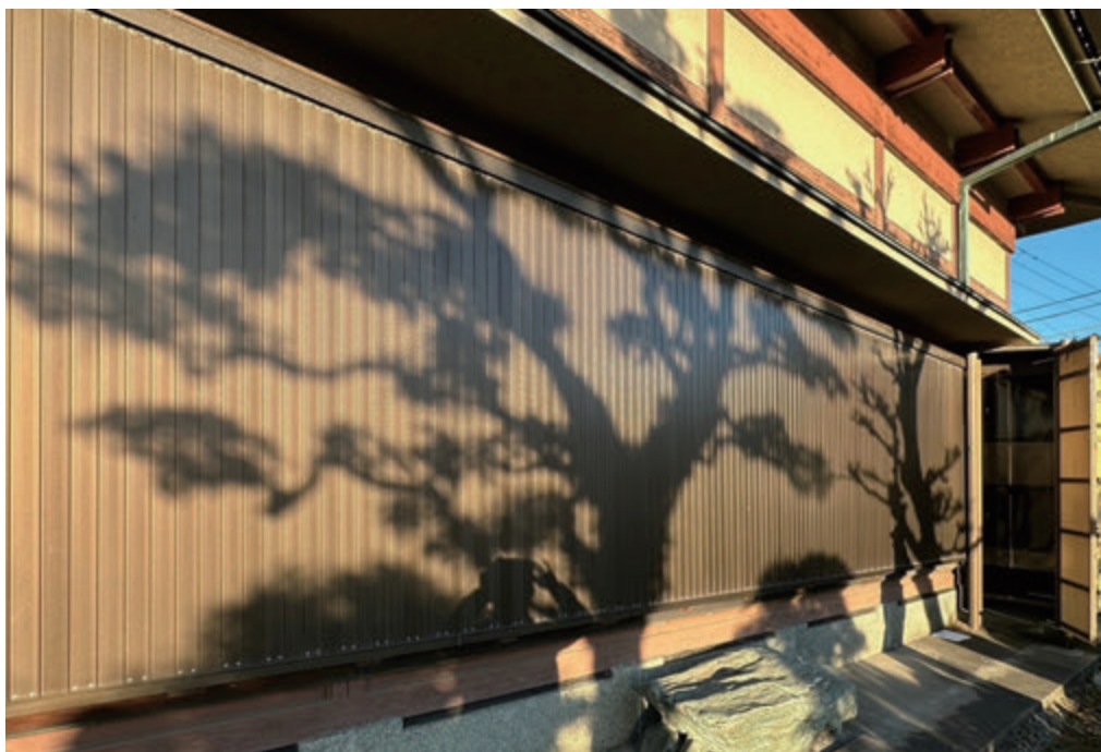
約・W9,000×H2,100 アルミ製（ブロンズ）電動式、片引き仕様、BOX型
