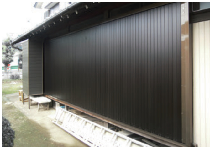
約・W7,000×H2,400 アルミ製（ダークブラウン）電動式、片引き仕様、BOX型
