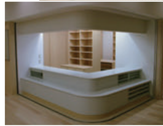
約・W5,500×H2,700 スチール製(ベージュ塗装) 手動式、片引き仕様、BOX型 t=0.8、防火戸仕様
