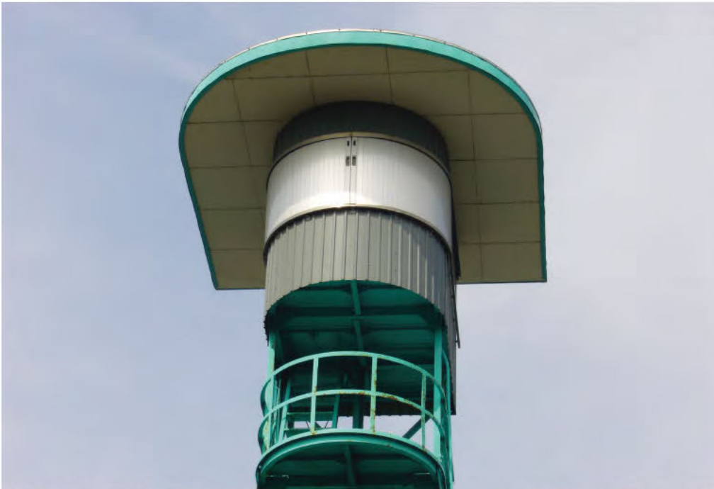
W2,500×H1,200 アルミ製(シルバー) 手動式、両引き分け仕様、流し込み型、全体R=2,000
