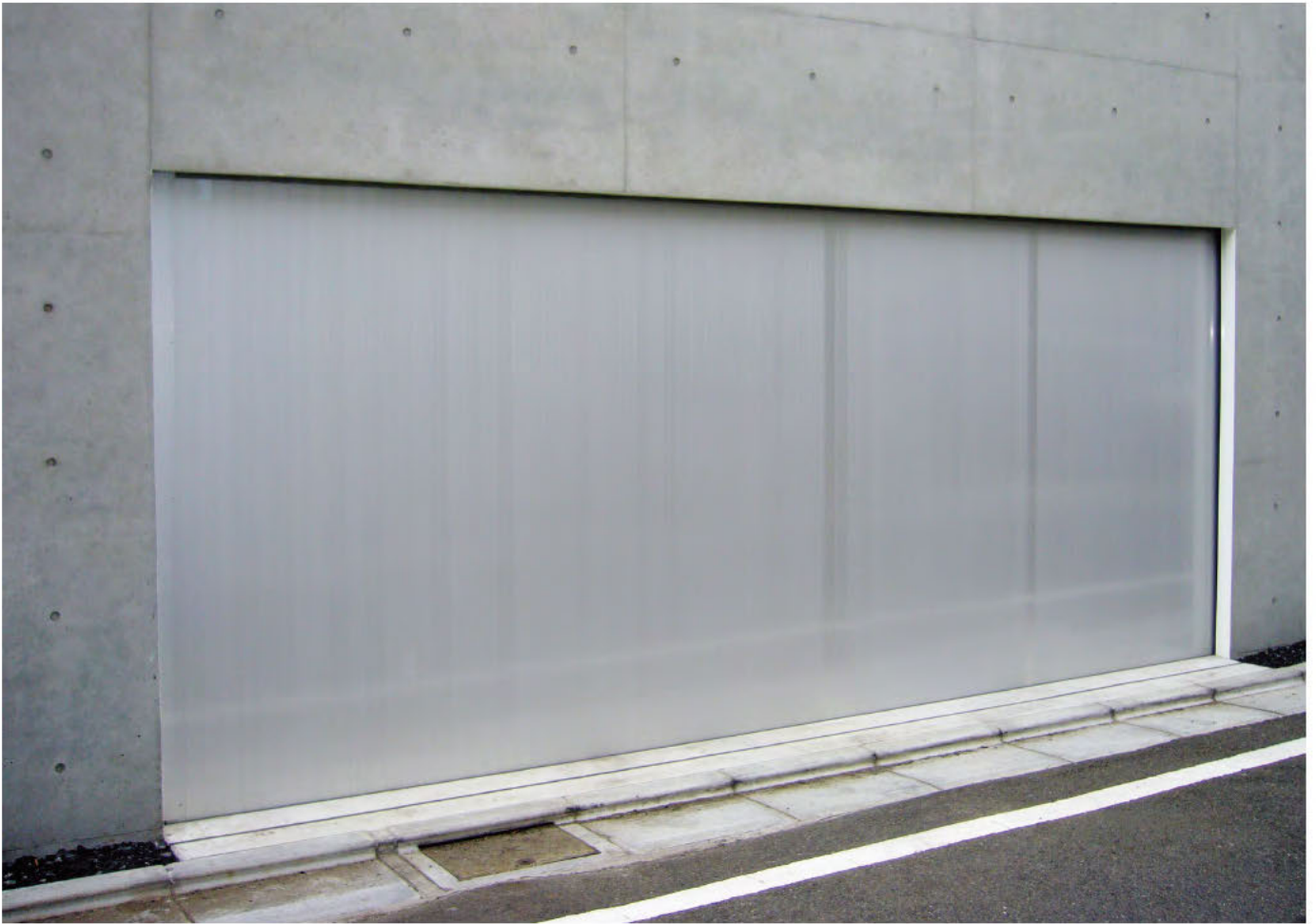
W5,000×H2,300 アルミ製(シルバー) 電動式、片引き仕様、BOX型
