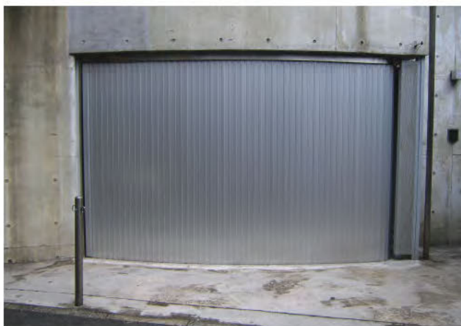
W3,000×H2,300 アルミ製(シルバー) 電動式、片引き仕様、 流し込み型、全体R=5,000
