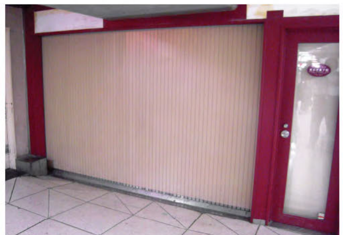
電動 W3,000×H2,100 スチール製(指定色:ベージュ)、片引き仕様、BOX型
