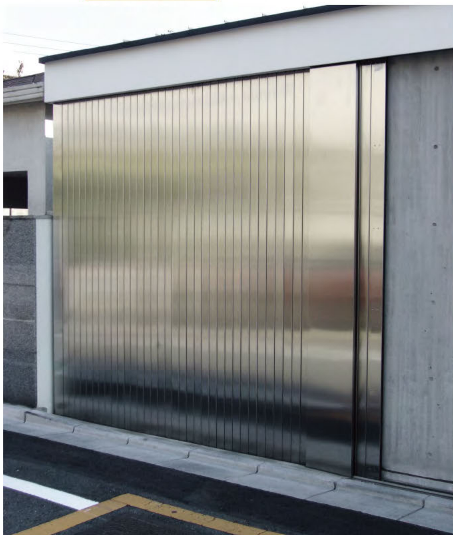
W3,000×H3,000 ステンレス製、電動式、片引き仕様、流し込み型、 防火戸仕様
