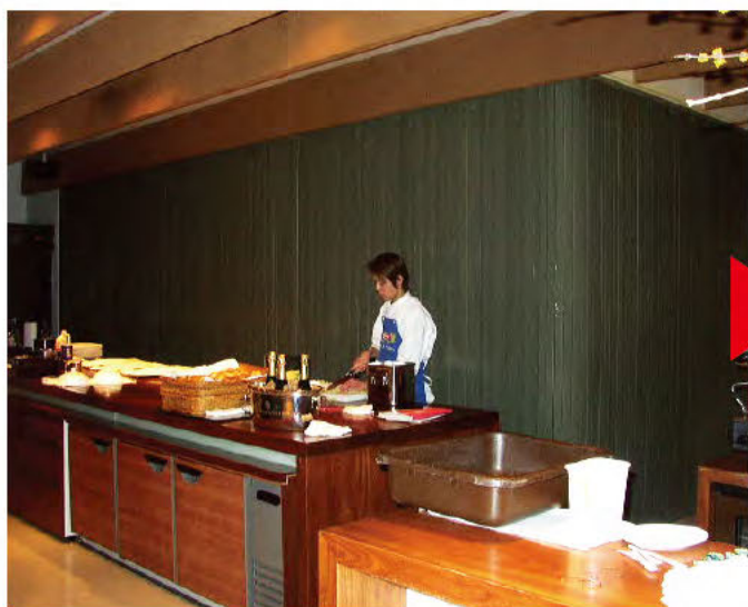
電動 W11,000×H2,900 スチール製(サビ止め塗装)、片引き、BOX型、特殊下レール仕様、曲げR=200
