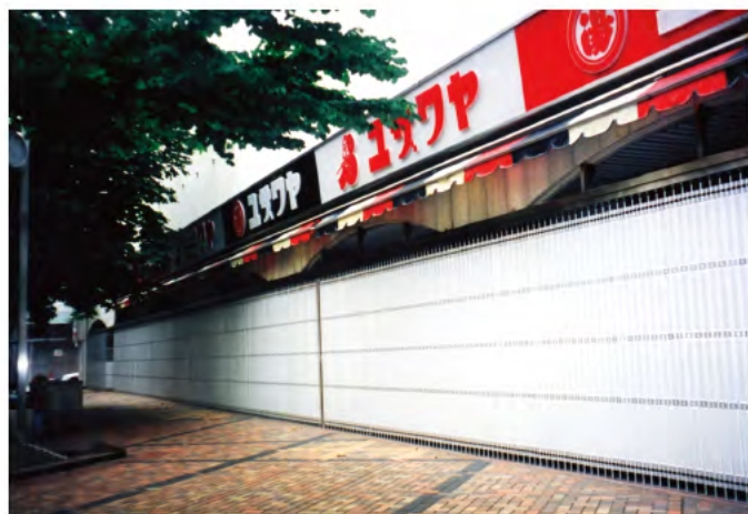
W25,000×H2,300 ステンレス製、両引き・角めし合わせ仕様、BOX型 ストレートタイプ、パンチングパネル入り
