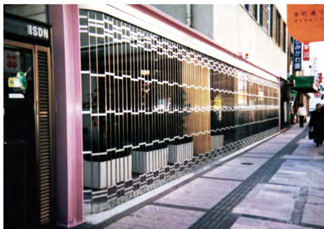
W12,000×H2,500 ステンレス製、片引き仕様、BOX型、千鳥タイプ
