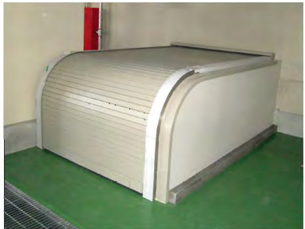
W1,600×H1,200×D6,200 スチール製、電動式、BOX型、 t=1.6 p=75、防火防煙仕様、非常電源バッテリー付き
