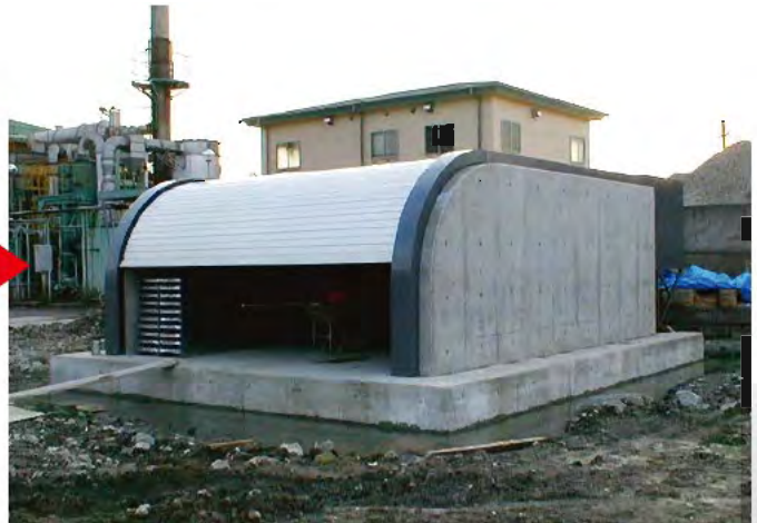
W3,600×H4,560×D2,460 アルミ製(シルバー) 電動式、BOX型、 特殊S字型仕様
