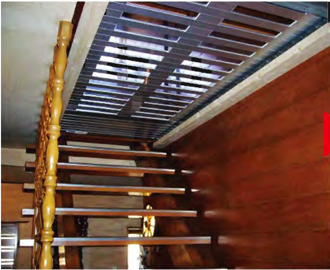
W1,200×D3,000 アルミ製(シルバー) 電動式、BOX型、透明パネル入りアミーダー仕様
