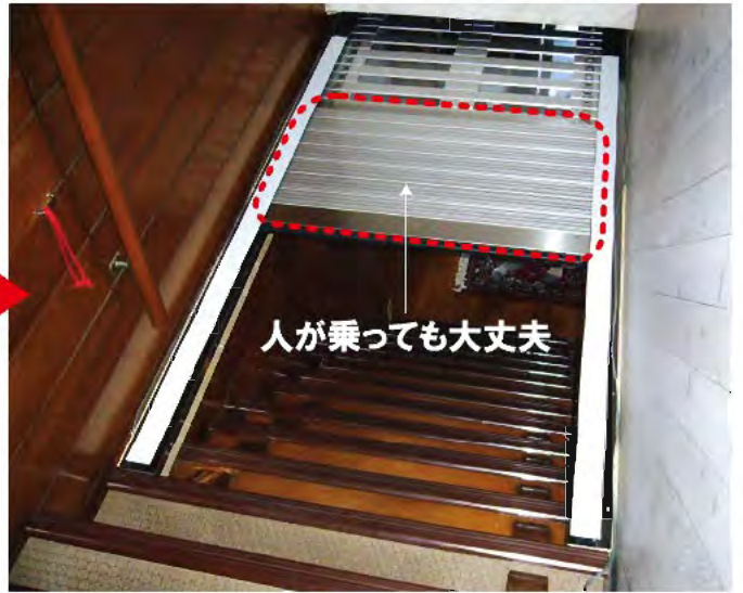
W1,200×D3,000 アルミ製(シルバー) 電動式、BOX型、透明パネル入りアミーダー仕様
