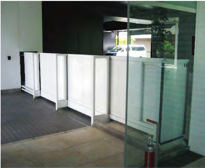
W8,000×H1,500 ステンレス製(指定色:ホワイト) 片引き、 折りたたみ4連型、くぐり戸付き、 ※引き戸仕様
