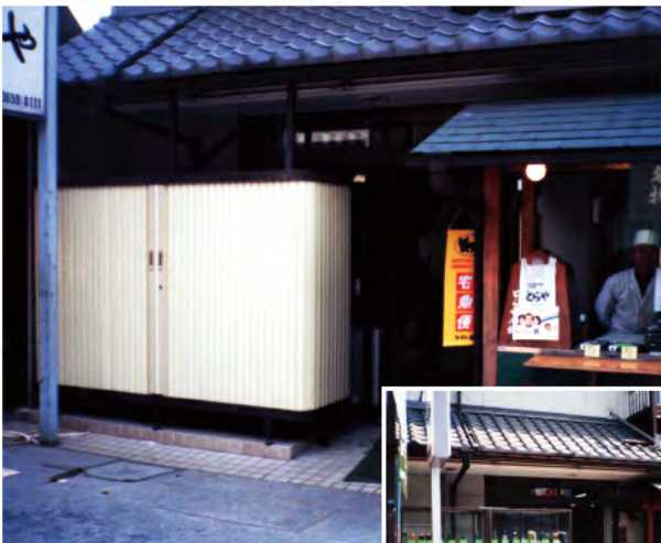
W3,000×H1,200 スチール製(アイボリー塗装) 手動式、両引き仕様、BOX型
