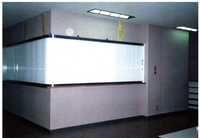
W8,000×H1,000 アルミ製(ホワイト) 手動式、片引き仕様、BOX型、曲げR=200
