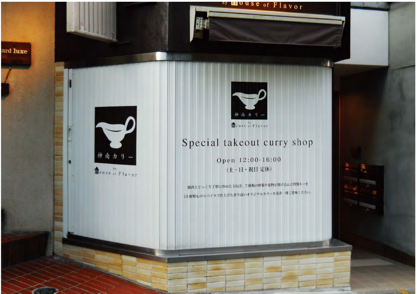
W4,800×H1,500 アルミ製(ホワイト) 手動式、片引き仕様、BOX型、曲げR=200
