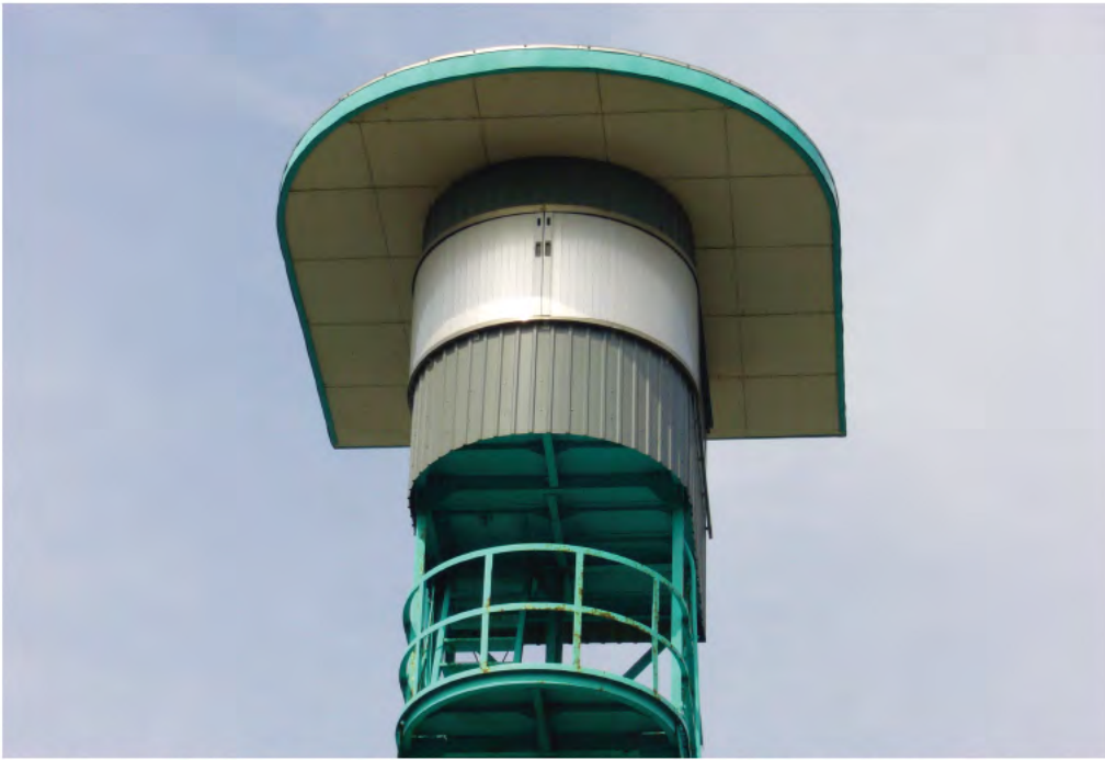
W2,500×H1,200 アルミ製(シルバー) 手動式、両引き分け仕様、流し込み型、全体R=2,000
