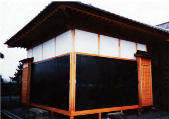
W2,700×H2,400 アルミ製(ダークブラウン) 電動式、片引き仕様、BOX型、2カ所
