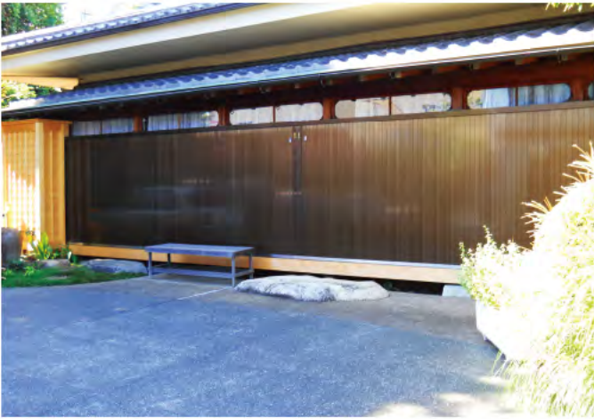
W9,000×H2,100 アルミ製(ブロンズ) 電動式、片引き、BOX型
