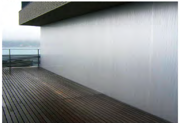
W11,000×H2,700 アルミ製(シルバー) 電動式、片引き、BOX型、曲げR=300
