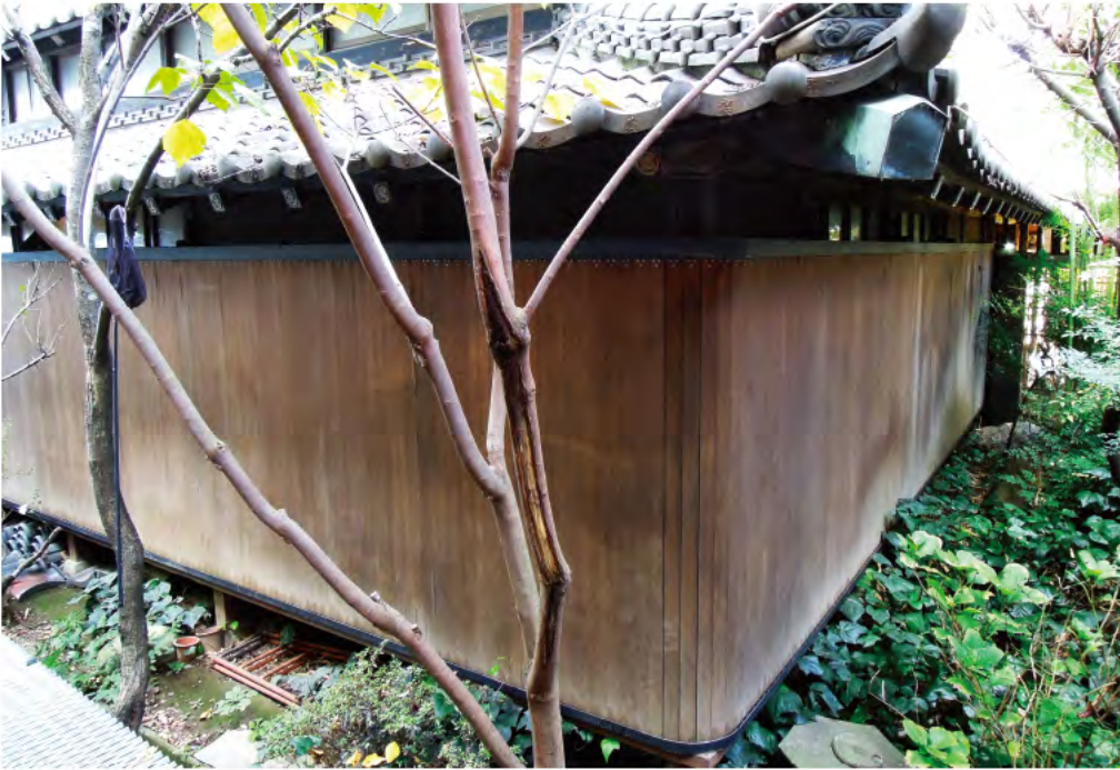
W15,000×H2,300 アルミ製(木製シート貼り) 電動式、片引き仕様、BOX型、曲げR=200
