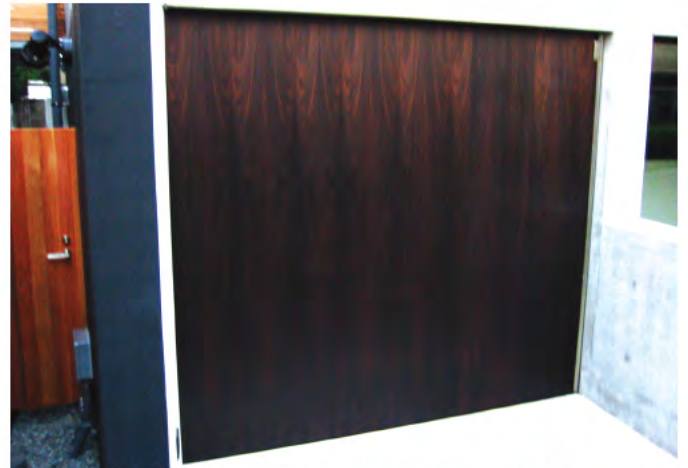
W2,500×H2,300 アルミ製(ダイノックシート貼り) 電動式、片引き仕様、流し込み型
