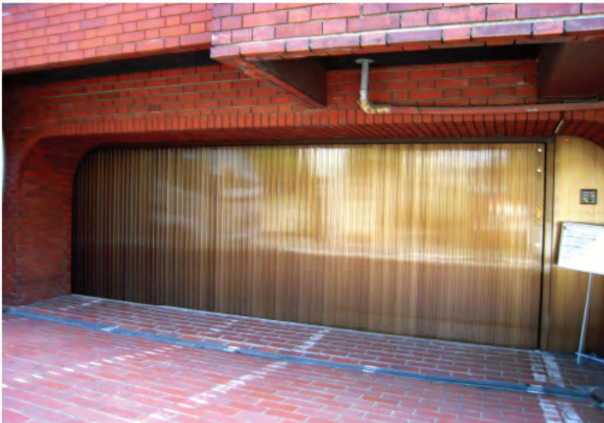
W6,000×H1,900 アルミ製(ブロンズ) 電動式、片引き仕様、BOX型
