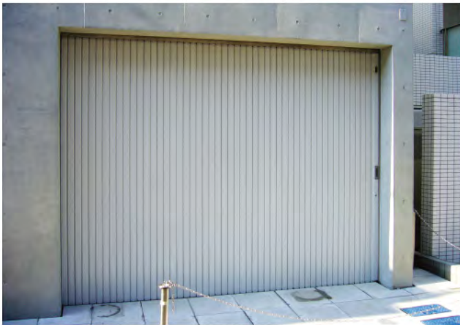
W3,200×H2,600 スチール製(標準色:シルバーグレー) 手動式、片引き仕様、BOX型、 t=0.8 、 防火戸仕様
