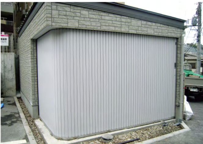
W4,000×H2,300 スチール製(指定色:ベージュ) 手動式、片引き仕様、流し込み型、 t=0.8、防火戸仕様
