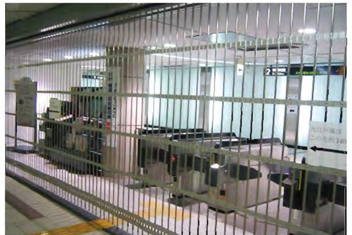
W28,000×H3,700 ステンレス製、片引き仕様、BOX型、ストレートタイプ、 下レールなし
