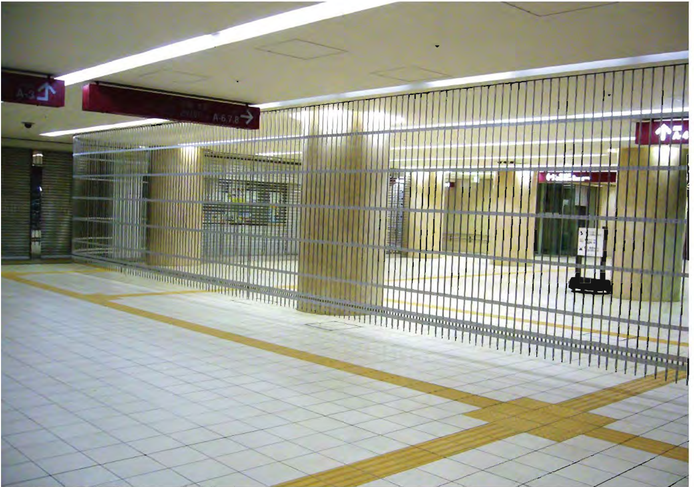
W28,000×H3,700 ステンレス製、片引き仕様、BOX型、ストレートタイプ、 下レールなし
