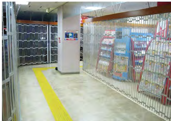
W9,000×H2,400 強化PC製パイプ、両引き仕様、下レールなし
