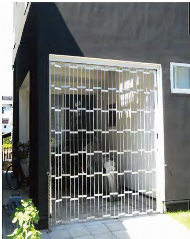
W2,500×H2,500 アルミ製パイプ、片引き仕様、下レールなし
