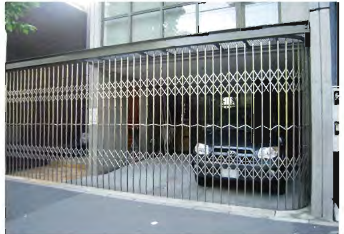
W9,000×H2,700 ステンレス製、片引き仕様、曲げR=900
