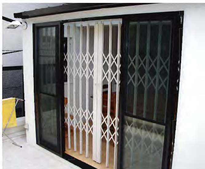
窓 W3,600×H2,200 スチール製(指定色:ホワイト) 両引き分け仕様、下レールなし
